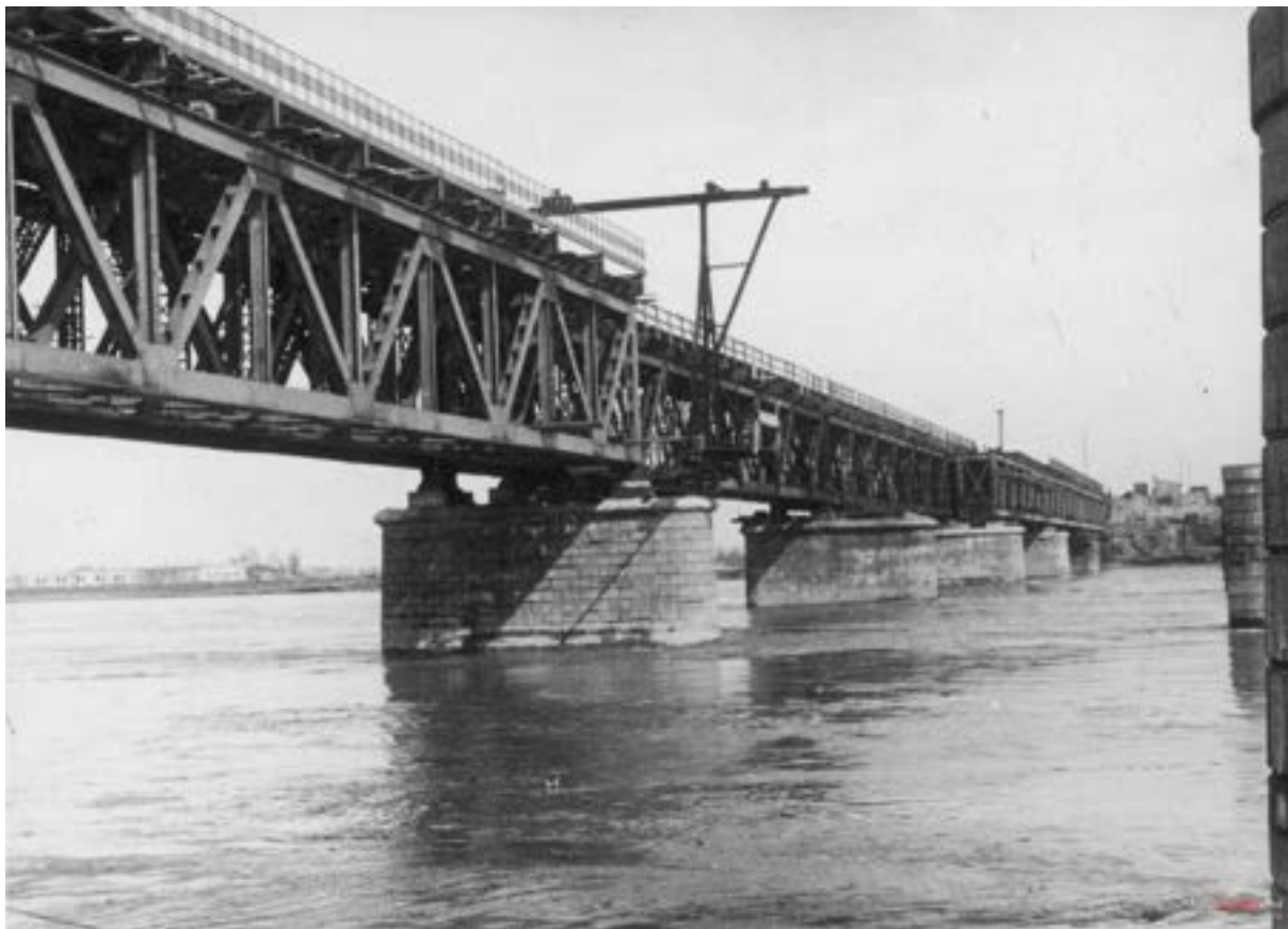
Odbudowa toru południowego, 1947 rok. Przęsła odbudowywano w kolejności od brzegów ku środkowi mostu (źródło: Narodowe Archiwum Cyfrowe)
