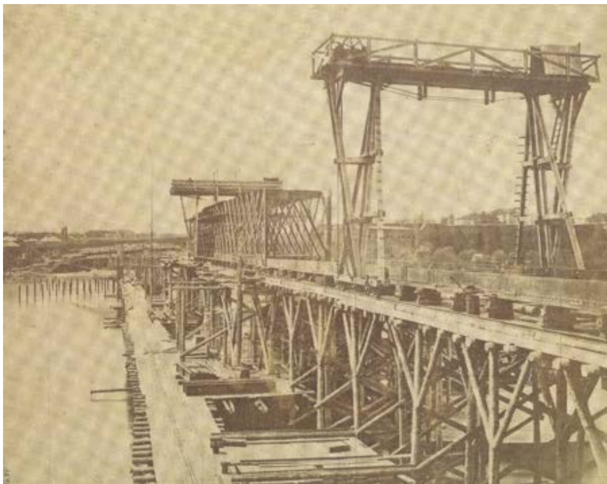
Budowa mostu w 1874 roku
