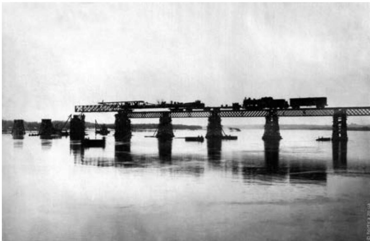
Pociąg z dźwigiem mostowym projektu G. Artiemienki podczas budowy mostu na Nowym Dnieprze. Ten sam dźwig w 1945 roku wznosił most w Warszawie (źródło: История жизни и боевой деятельности Мостопоезда №7 (28.10.1941 - 28.10.1944 г.) - Машинопис. - Фонду НЗХ НА-189)
