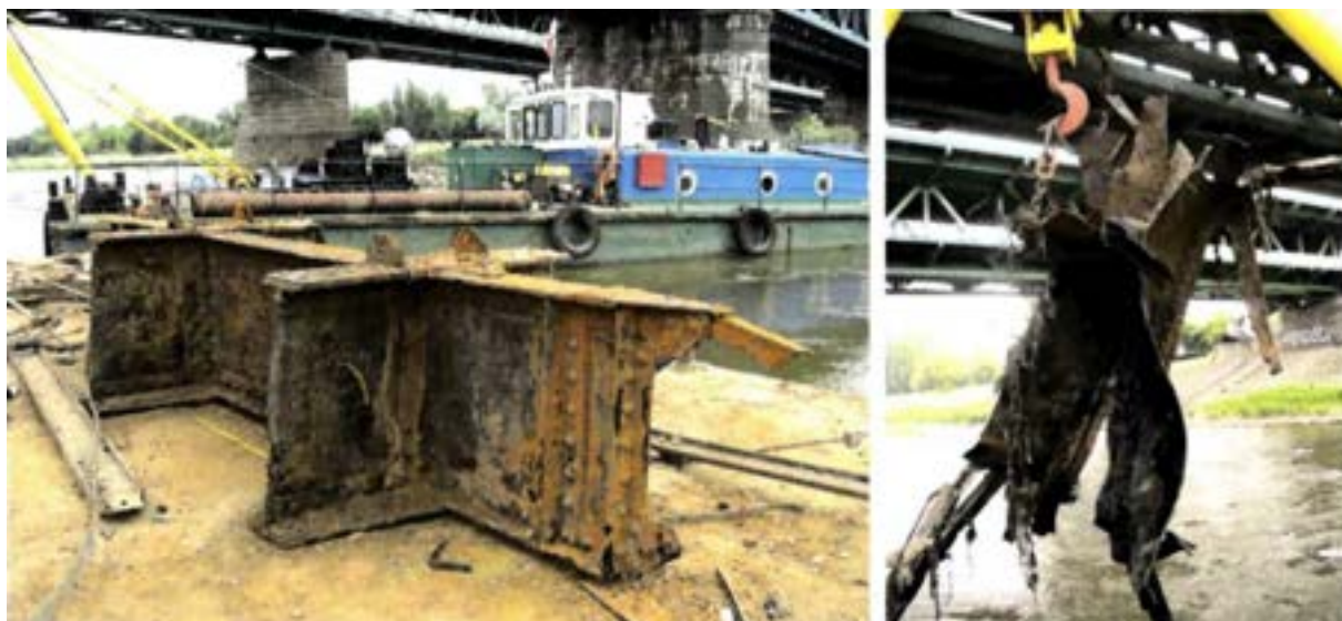
Fragmenty konstrukcji mostu pod Cytadelą podczas wydobywania. Z lewej: fragmenty blachownicowych przęsłek podtorowych, z prawej: fragment pasa głównego zdeformowanego wskutek wybuchu zaraz pod wydobywaniem z dna (źródło: Z. Tucholski, M. Ratajczak, S. Fuglewicz, G. Radomski, op.cit., s. 11.)
