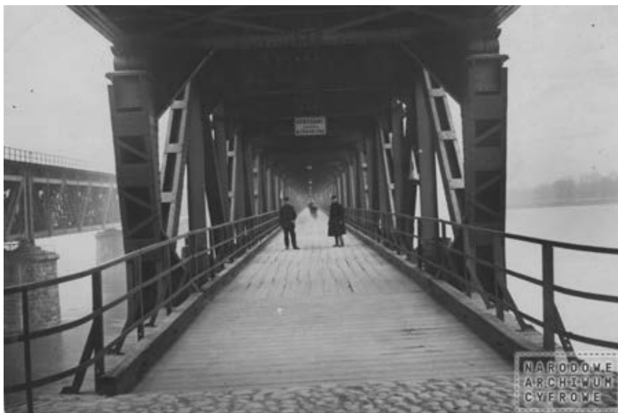
Widok dolnego poziomu mostu, 1926 (źródło: Narodowe Archiwum Cyfrowe)
