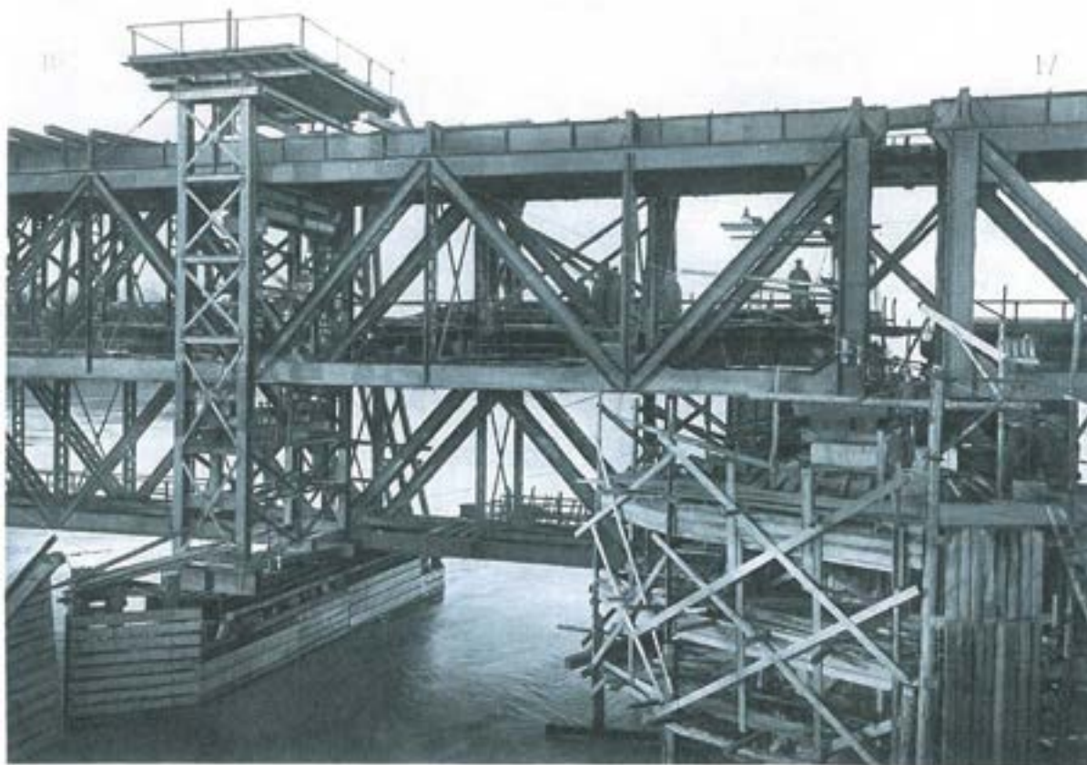
Przęsło trzecie podniesione na docelową wysokość; z prawej widoczny fragment przęsła czwartego (źródło: G. Barkhausen, op.cit., s. 12.)
