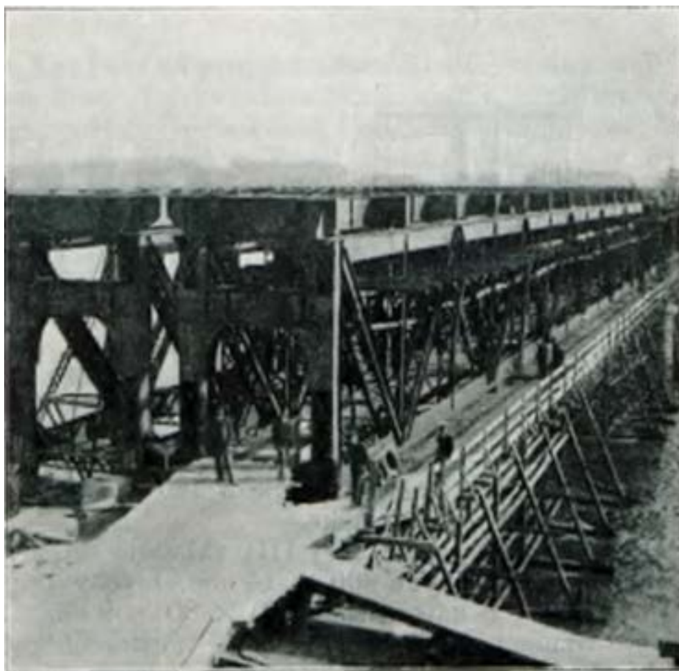
Zmontowane przęsła nadwodne na obu torach (źródło: J. Eberhardt, Nowy most..., s. 26.)
