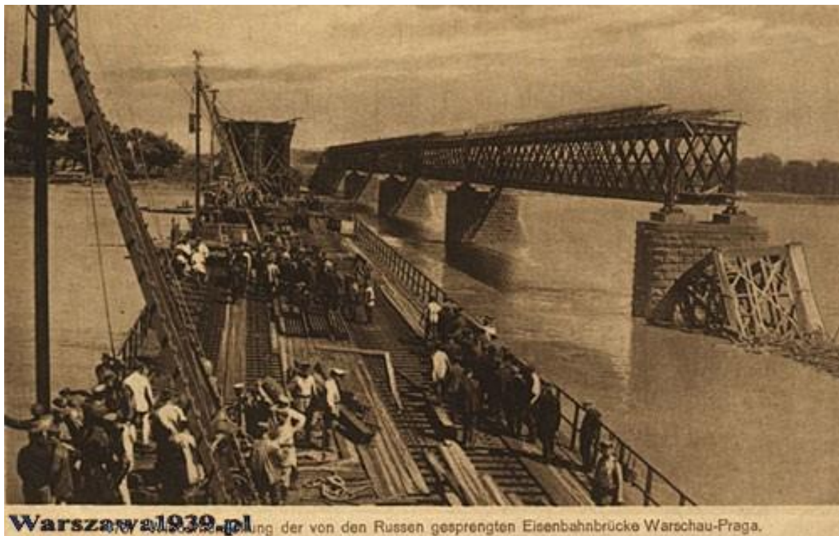
Prowizoryczna odbudowa mostu z 1908 roku (źródło: kartka pocztowa)
