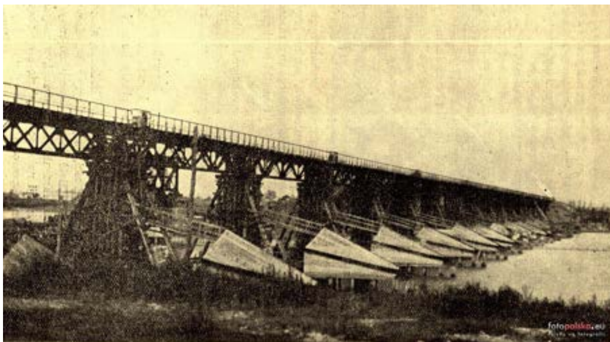
Tymczasowy most kolejowy przy Cytadeli, 1945. Widoczne są izbice zbudowane z polecenia ppłk. Żółtikowa (źródło: W. Sterner, op. cit., s. 147.)
