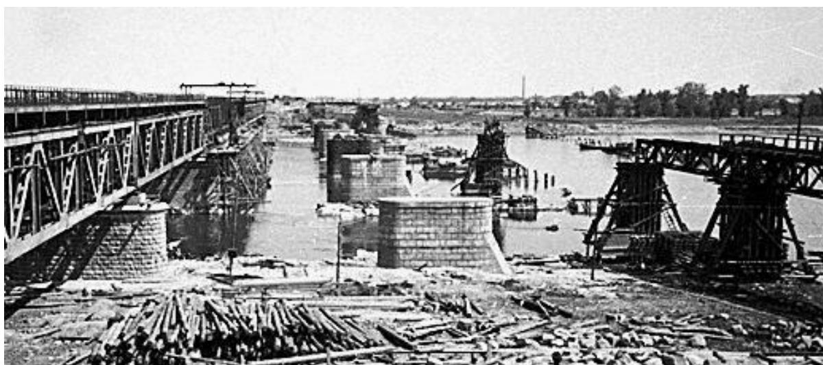
Fotografia z 1947 roku. Z lewej nowszy most przy Cytadeli w trakcie odbudowy; w środku filary zniszczonego starszego mostu przy Cytadeli; z prawej – pozostałości zniszczonego przez wiosenne roztopy mostu tymczasowego (źródło: PAP)
