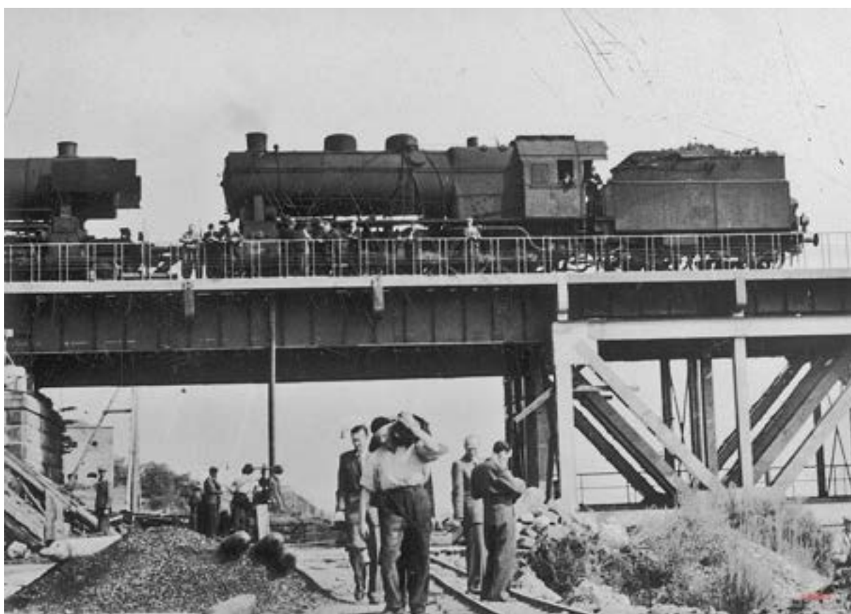
Próby statyczne i dynamiczne mostu, 21 lipca 1947 (źródło: Narodowe Archiwum Cyfrowe)
