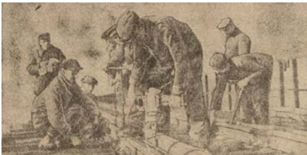
Budowa toru kolejowego na wykonanych przęsłach mostu, przełom września i października 1946 (źródło: „Wieczór Warszawy” 1946, nr 15, s. 1.)
