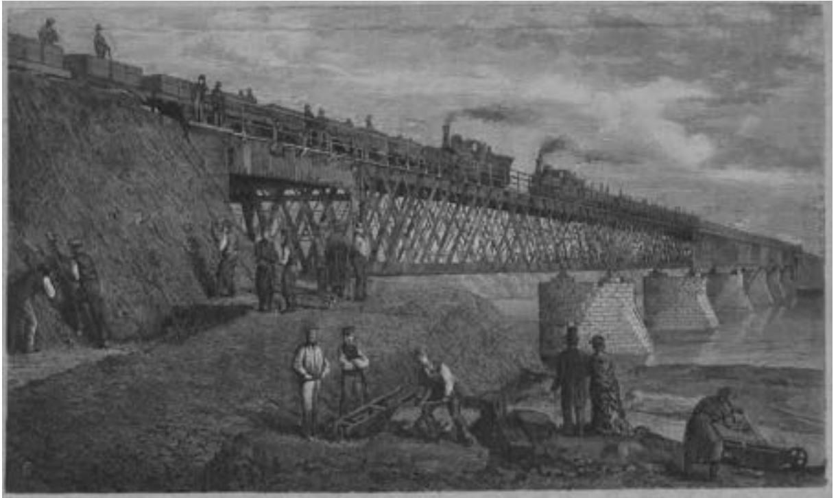
Rysunek autorstwa Dymitrowicza przedstawiający „nowy most żelazny na Wiśle” w trakcie prac wykańczających (źródło: „Tygodnik Illustrowany” 1875, nr 392–417, tom XVI, seria 2, s. 353.)
