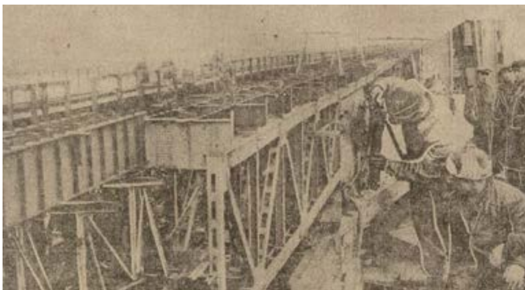
Montaż piątego przęsła, początek listopada 1946 (źródło: „Wieczór Warszawy” 1946, nr 46, s. 1.)
