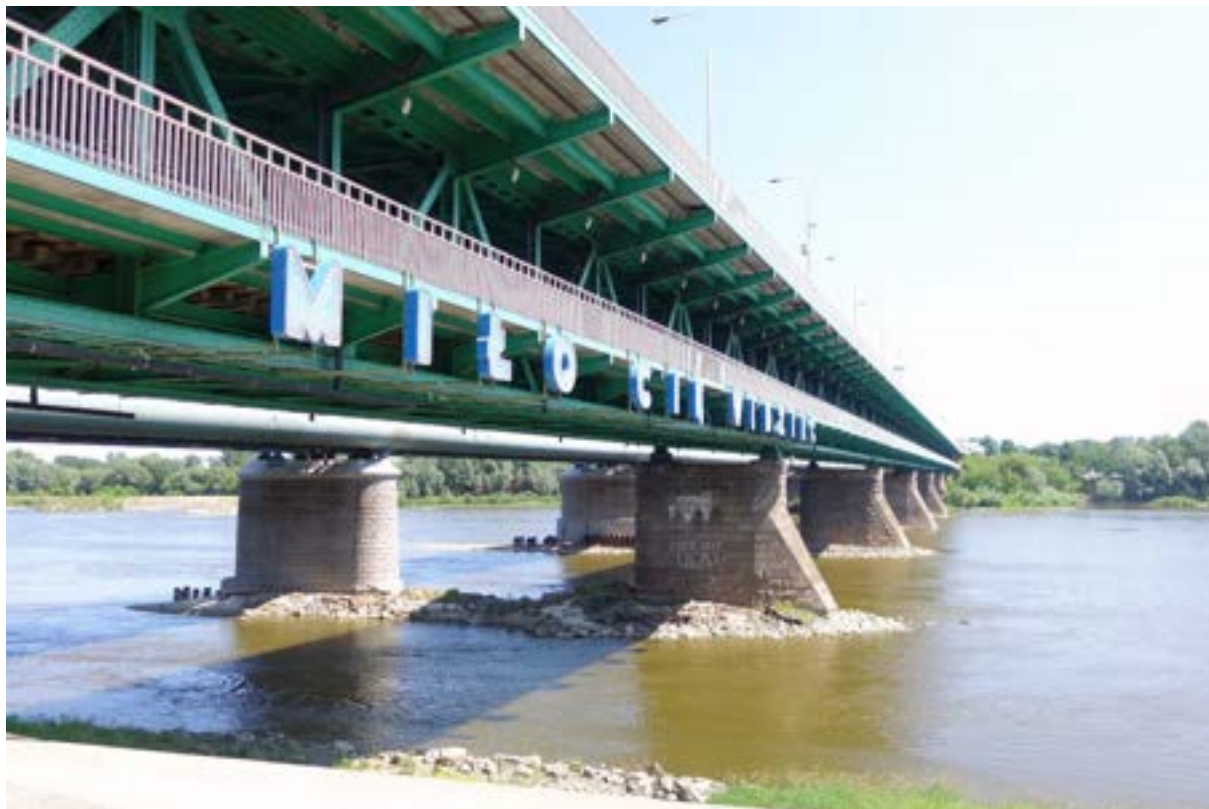
Most Gdański zbudowany na podporach dawnego mostu kolejowego przy Cytadeli z 1875 roku (źródło: Kocio, CC BY 3.0, via Wikimedia Commons.)
