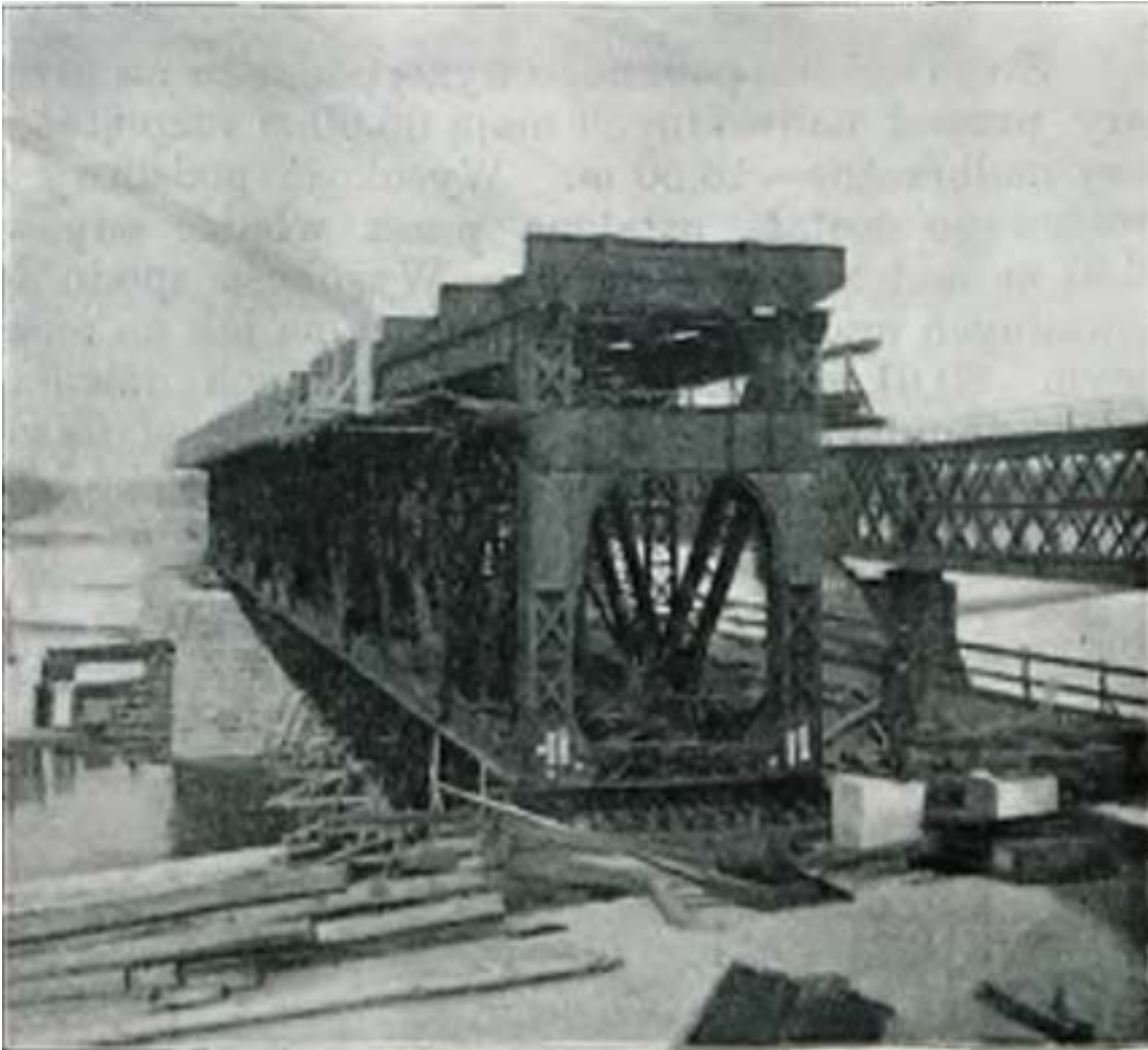
Zmontowane przęsło nadwodne na północnym torze (źródło: J. Eberhardt, Nowy most..., s. 26.)
