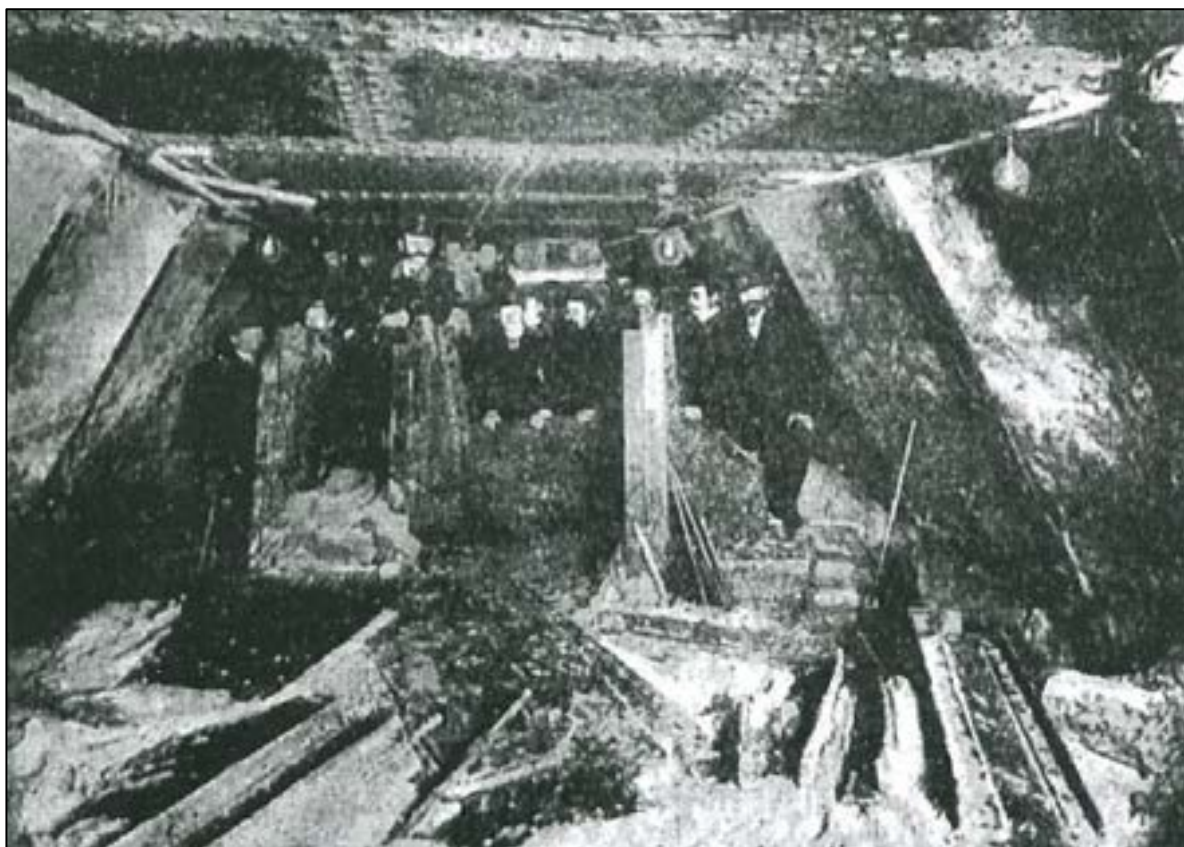
Wnętrze komory roboczej w trakcie usuwania starego kesonu. Fotografia została wykonana na kliszy i oświetlona rozbłyskiem płomienia magnezu. Na pierwszym planie widoczne są części starego kesonu przygotowane do wyśluzowania, w głębi – klocki stanowiące wierzch jednego z dwóch stosów podpierających sufit kesonu podczas usuwania przeszkody (źródło: „Przegląd Techniczny” 1905, nr 48, tom XLIII, s. 574.)
