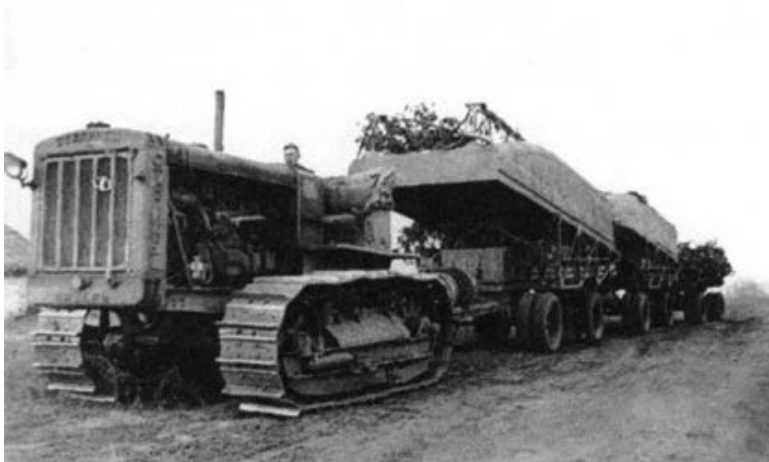
Park mostowy N2P-41 podczas transportu na przyczepach ciągniętych przez traktor „Staliniec” (źródło: Павел Шехман at Russian Wikipedia., Public domain, via Wikimedia Commons)
