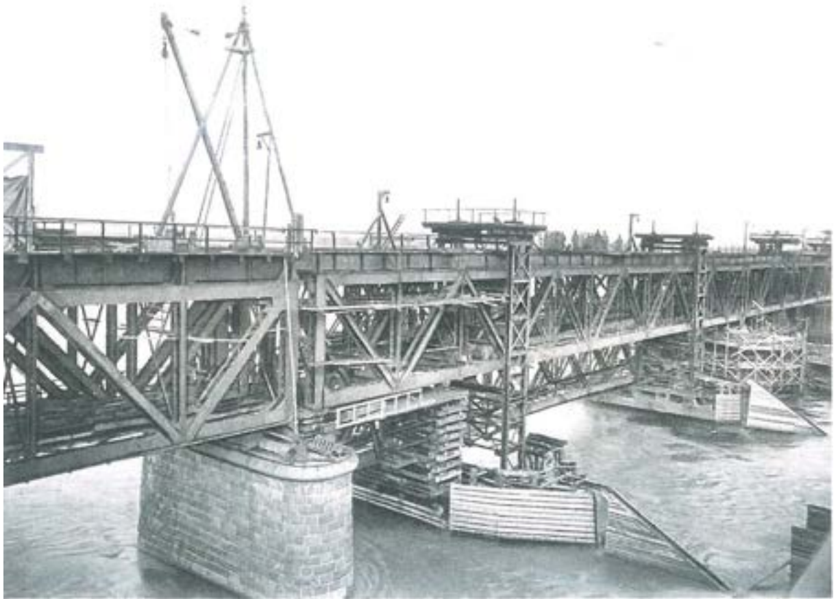
Widok mostu wraz z konstrukcją wież do podnoszenia przęseł trzeciego i czwartego (źródło: G. Barkhausen, op.cit., s. 10.)
