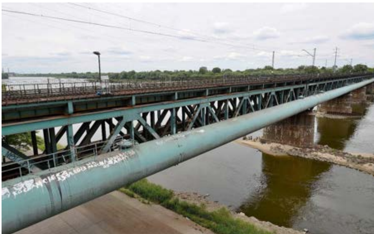
Most przy Cytadeli w 2015 roku z widoczną na pierwszym planie rurą samonośną (źródło: Adrian Grycuk, CC BY-SA 3.0 PL, via Wikimedia Commons)
