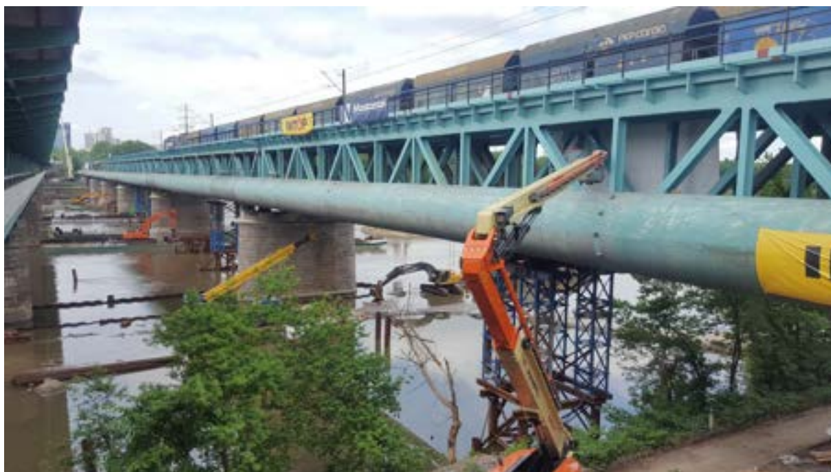
Prace remontowe przy moście (24 maja 2019, fot. Rafał Ziarnik, Wikimedia Commons)
