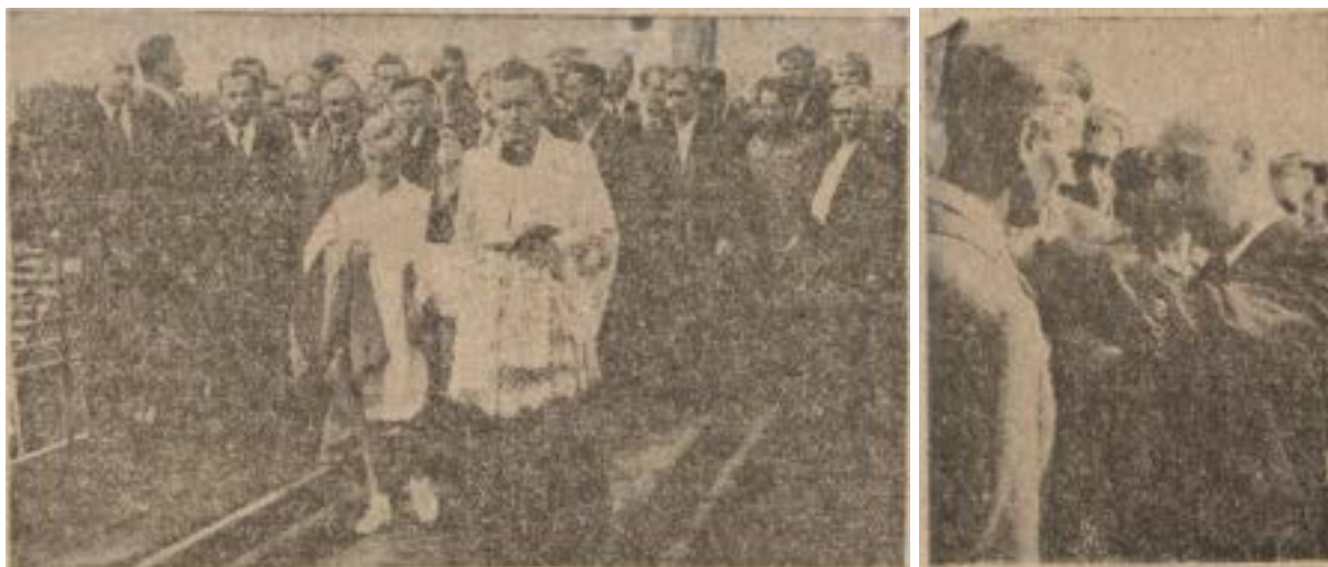
Uroczystość poświęcenia mostu. Na zdjęciu z lewej: ksiądz Grabowski dokonuje poświęcenia mostu. Na zdjęciu z prawej: premier Józef Cyrankiewicz oznacza inż. Stefana Fariaszewskiego Krzyżem Zasługi (źródło: „Życie Warszawy” 1947, nr 200 (986), s. 1.)
