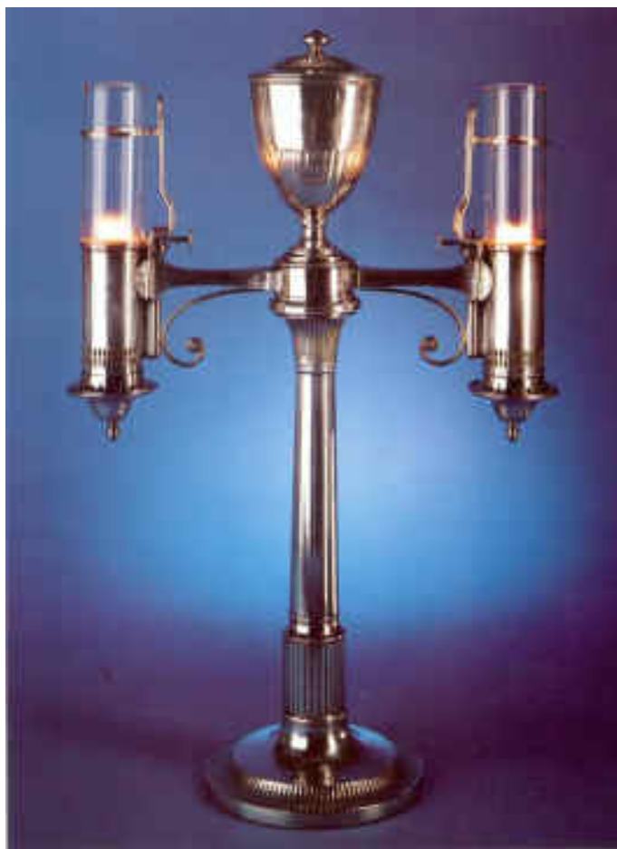
Ilustracja 2. Dwuramienna lampa Arganda, wyposażona w klasyczny mechanizm podnoszenia knota i proste szkła ciągowe, utrzymywane z pomocą chwytaków. Produkcja Matthew Boulton 1784 r. Źródło: J. J. Wolfe, op. cit., tabl. 6, s. n. n.
