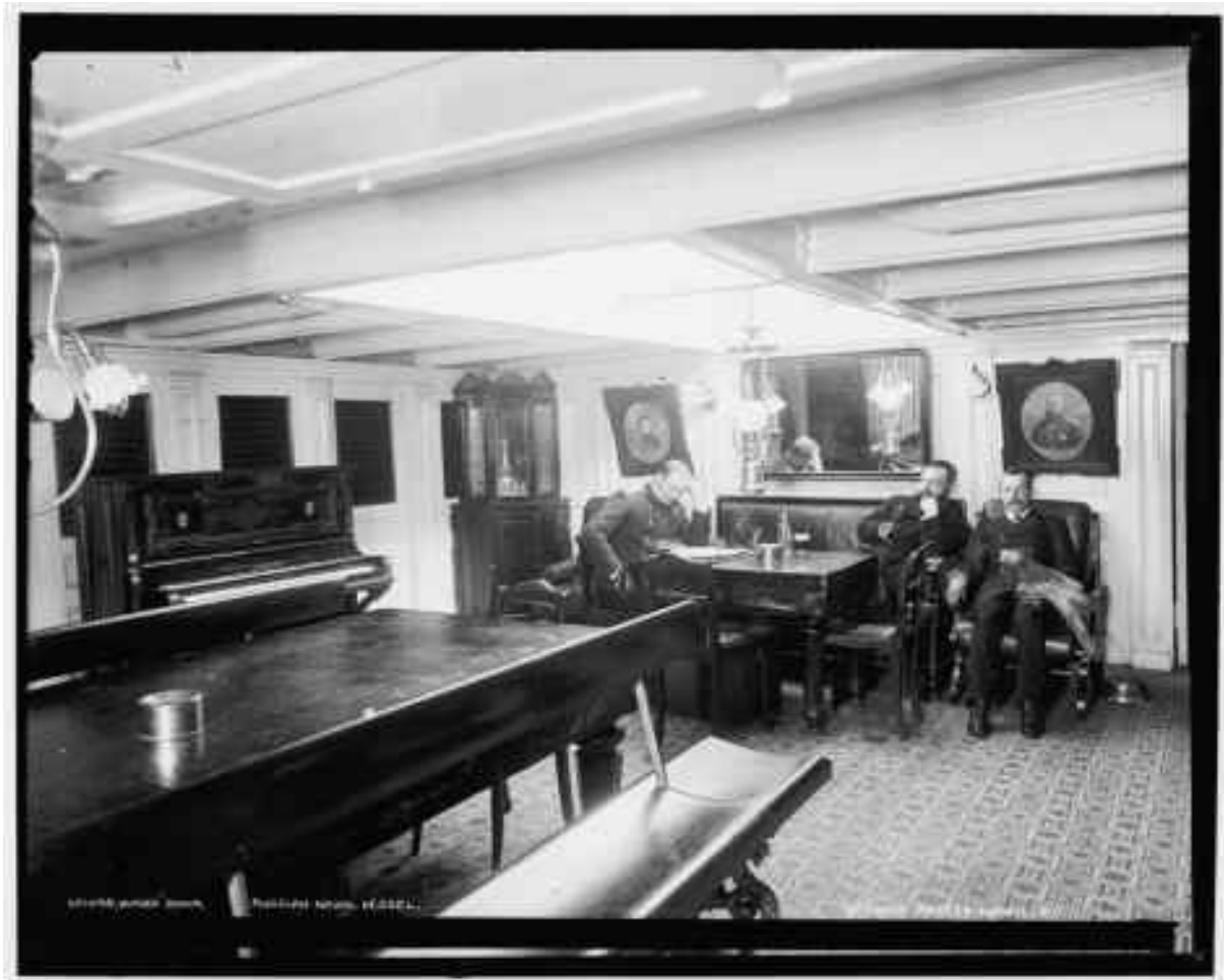
Ilustracja 57. Mesa oficerska jednego z okrętów rosyjskiej marynarki wojennej z oświetleniem hybrydowym (1893 r.). Z lewej strony kadru wyraźnie widoczna część elektrycznego żyrandola, zaś nad stołem, przy widocznych postaciach, została zawieszona lampa olejowa mechaniczna lub naftowa. Źródło: Library of Congress.
